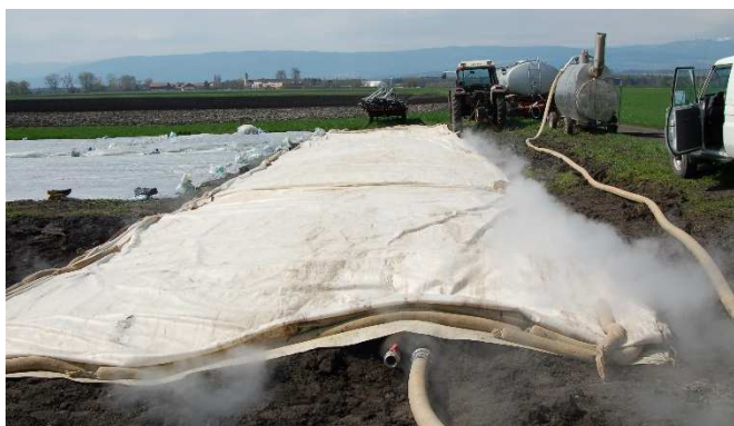
Abbildung 2: Grössere mit Erdmandelgras befallene Flächen können effizient mit der Blachendämpfung sterilisiert werden (Foto: L. Collet, Grangeneuve).
